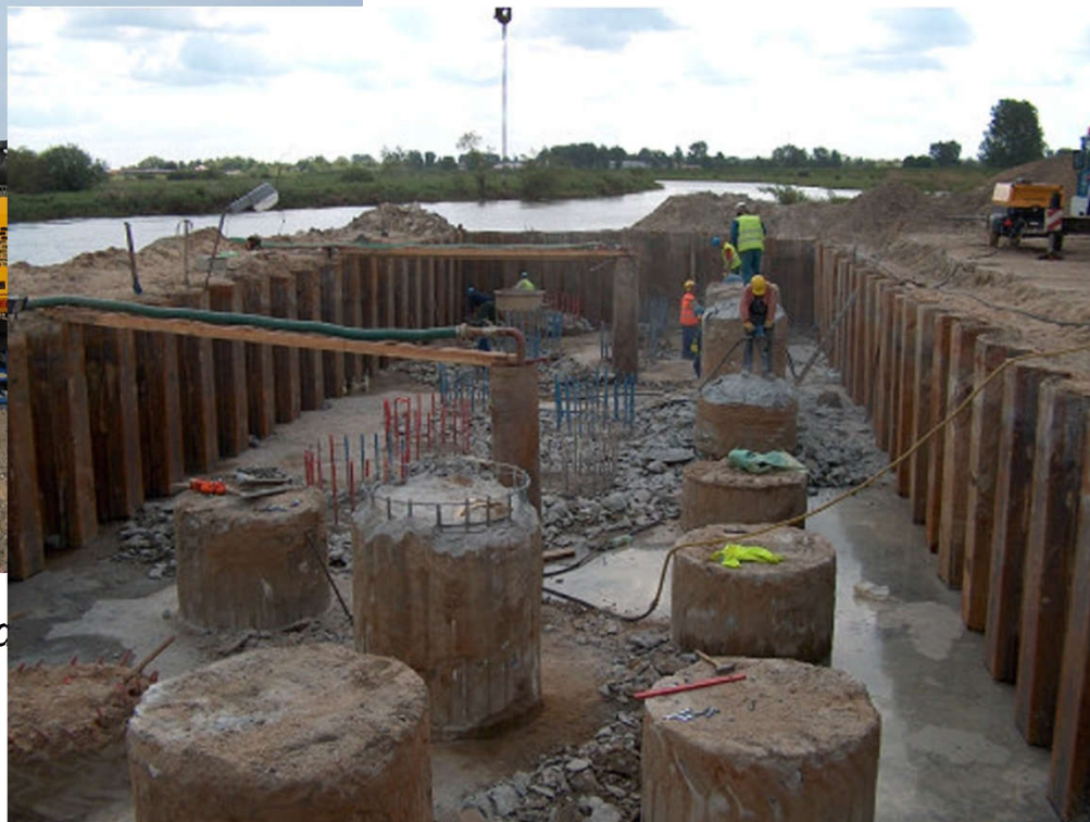
Pale wielkośrednicowe pod podporę mostową
